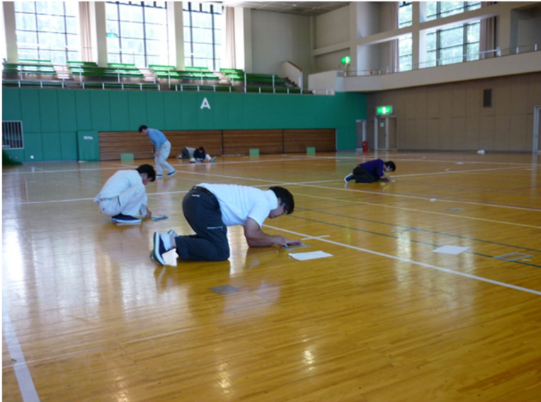
写真 従来の点検員の瑕疵点検方法
