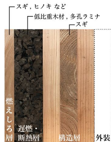
図2 準耐火 CLT 外壁部材の構成
