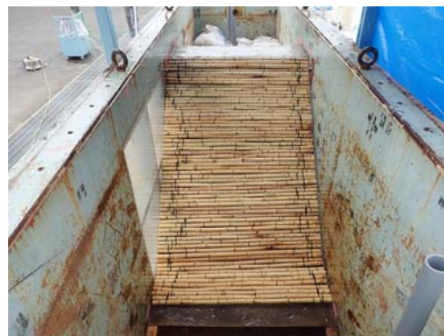
写真 1 竹材の法面への設置状況
