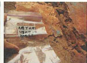
写真 4 試料 4 (A 棟下段北面 2 階内壁化粧モルタル)
