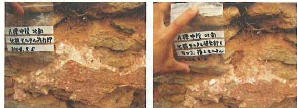
写真 1 試料 1 (A 棟中段北面外壁化粧モルタル)
