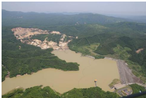
図1 岩手宮城内陸地震による荒砥沢地すべりの全景 (福岡撮影)
