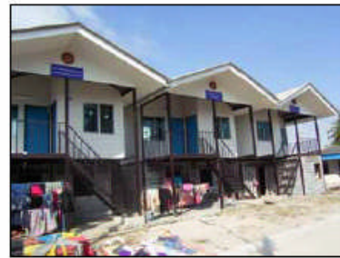
写真2 NGOの支援により建てられた家屋。津波の被害を受けたナイライ村の海側の集落は、こうした家屋で埋め尽くされている。(2007年 筆者撮影)
