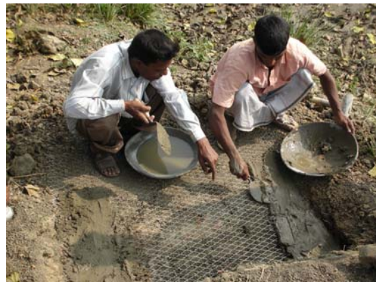
図 7。新工法で用いる材料「メッシュとモルタル」
