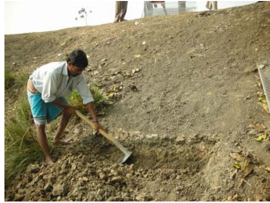
図 6。ゴダガリでの法面保護の実施例
