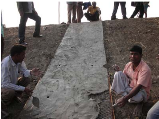
図9。法面にモルタルの設置
