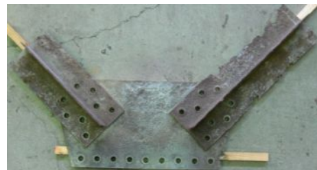
写真-1 リベット接合部
