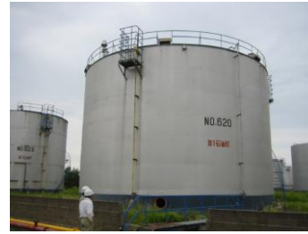
写真-1 1600KL インナーフロートタンク
