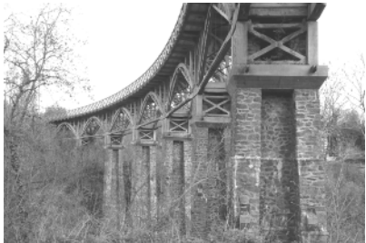
写真-3 ポン・ヌフ高架橋
