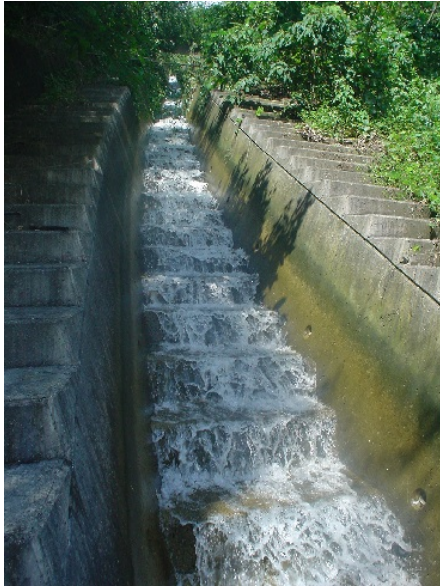
図—1 急傾斜地の階段状水路
