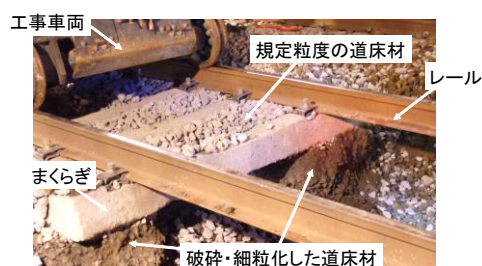
図 1 破碎・細粒化した道床材
