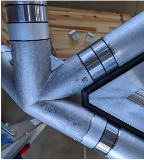
図9 AM仕口・サブ仕口と外壁パネル
