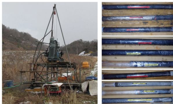
図 4 三野断層破砕帯でのボーリング調査
