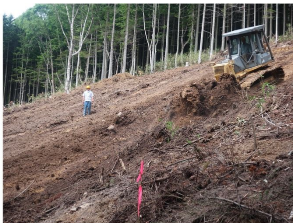
図1: ブルドーザーで人為的に山腹崩壊地を設定
