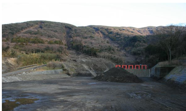
図-2 一般的な流木捕捉施設は遊砂池等の大規模施設と共に設置される(大金沢, 2013年の伊豆大島土砂災害後撮影)
