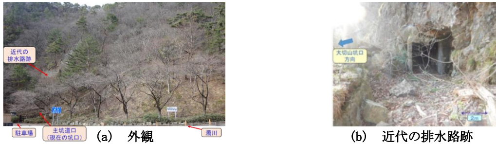
図5 主坑道周辺地表面の様子
