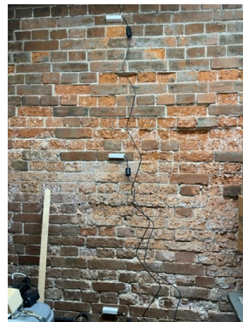
図 1 神戸煉瓦倉庫の煉瓦壁
