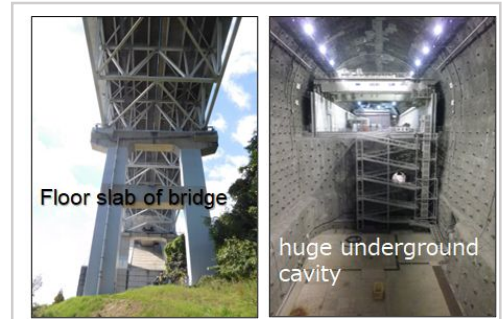
図1 コンクリート構造物の非破壊検査
