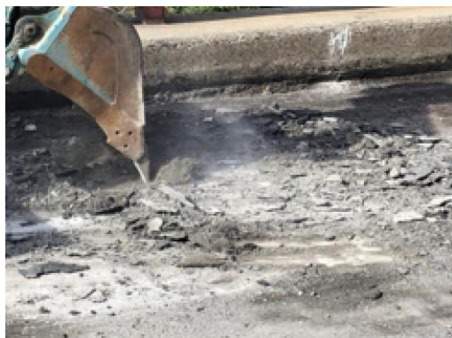
写真-1 バックホウによる切削残存層の撤去
