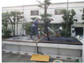
図3 アスファルト舗設状況
