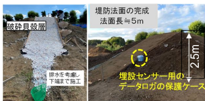
図-12 斜面上の破碎貝殻と完成盛土状況
