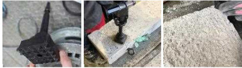
図 9 表層の目荒らし状況
