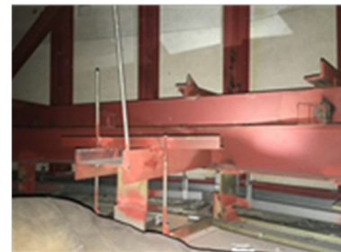
写真1 大判ガラス上部(天井裏)の状況
