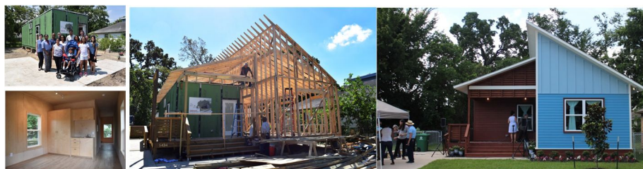
図4. ハリケーン「ハービー」後にヒューストンで建設された「RAPIDOハウス」
