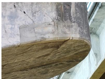
図1 断面修復部の劣化
