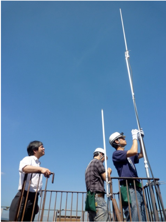
図2 中継局アンテナの設置風景
