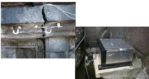
図5 プランバナン寺院に設置したクラックゲージと地震計
