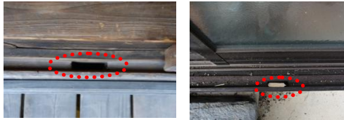
写真9、10 木製とアルミサッシ製敷居の排水口
