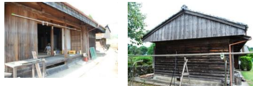
写真5、6 木製の雨除け板
