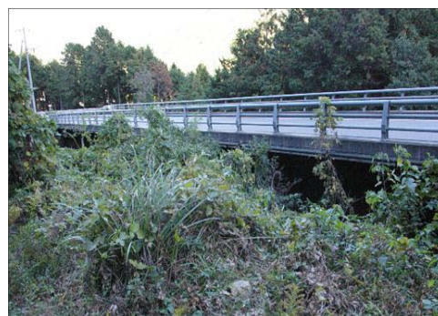
写真1 橋梁Aの外観写真
