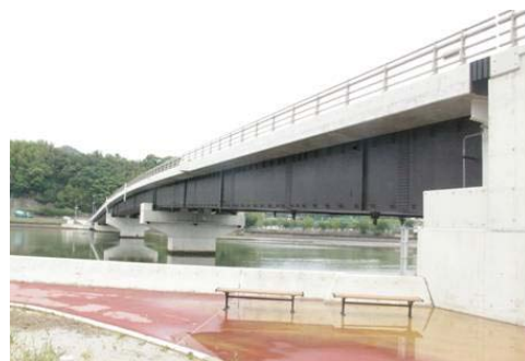
写真2 橋梁Bの外観写真
