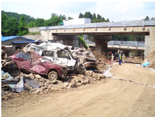
写真-1 2006年8月、中央自動車道沿線岡谷付近
