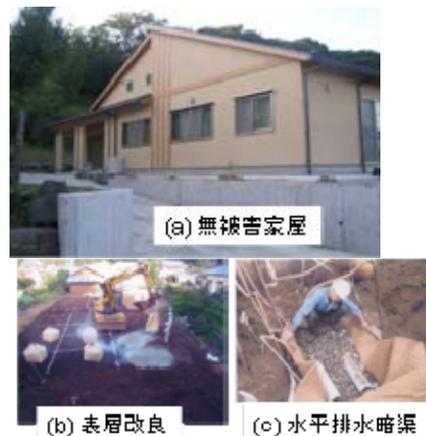
写真二 2 2007 年新潟県中越沖地震で液状化被害を免れた例
