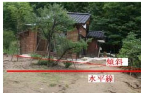
写真一 1 2007 年新潟県中越沖地震による液状化被害例
