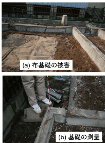
写真一4 基礎の被害調査
