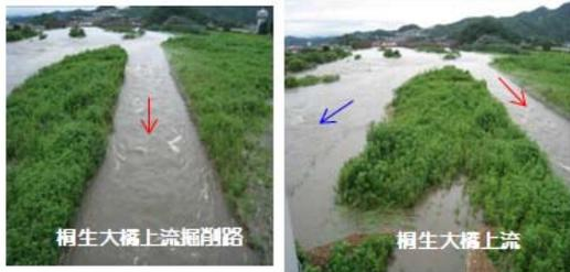
図 12 小規模掘削路による砂州への洪水誘導
