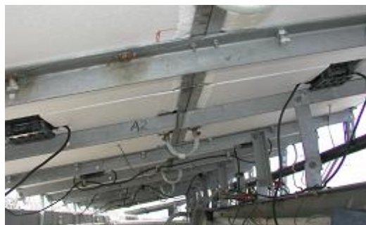
図6 断熱材を取り付けた太陽電池裏面
