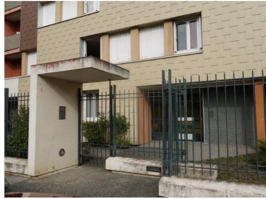
【写真 1】フェンスとゲートが設置された住棟：典型的なレジデンシャリザシオン(現地調査⑥)
