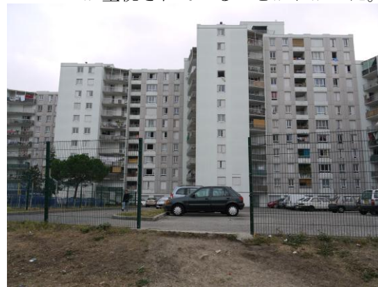
【写真2】住民が通行の便のために破壊したフェンス
