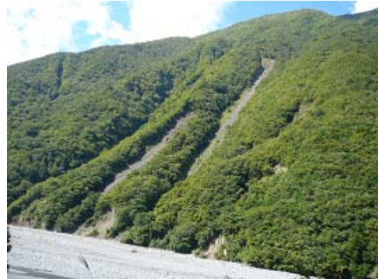
図1 表層崩壊の事例（静岡市井川地区）
