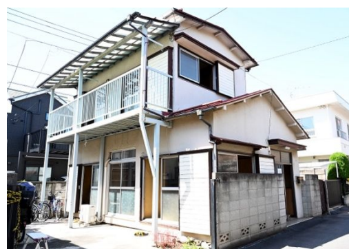
図4 調布市実験対象施設
