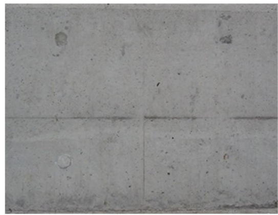
(b) 建設当初 含浸材 施工箇所
