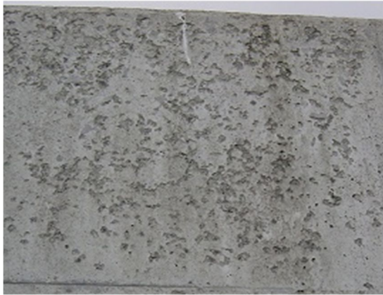
(a) 建設当初 含浸材 未施工
