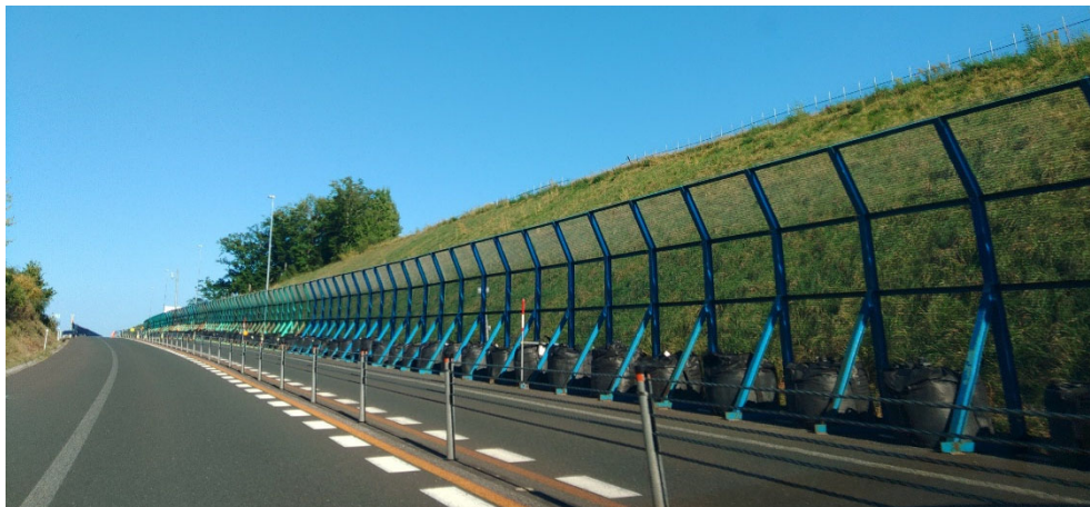
写真1 社会実装された複層式のり面保護工
