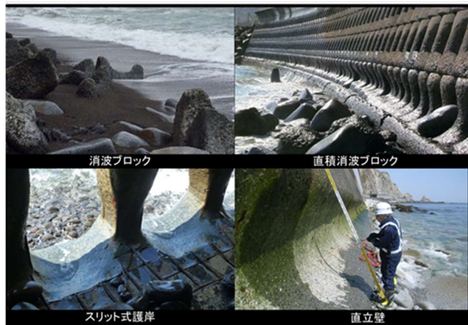
写真-1 各種護岸形式における摩耗状況
