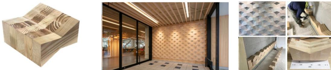
(a)CLT エストブロック (b)尾鷲市庁舎玄関口(設計・施工: 榊竹中工務店)
