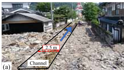
図-6 土石流により埋まった水路
