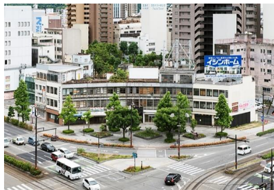
柳川ロータリービル
