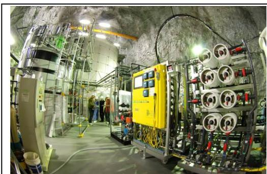
EGADS 実験施設の写真。左が 15 m<sup>3</sup>溶解槽、奥が 200 m<sup>3</sup>タンク、右が循環装置。
