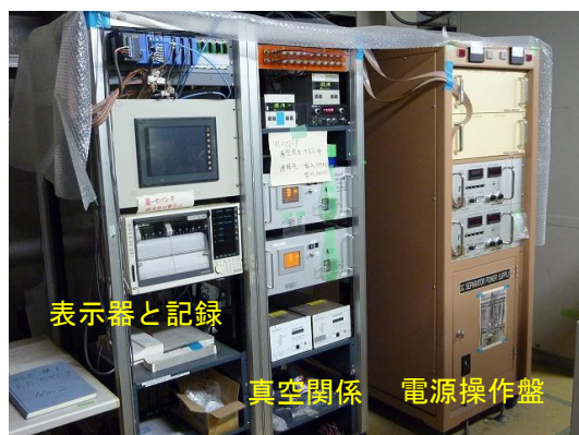
図 5 静電粒子分離装置の制御用ラック。右端が電源操作盤本体、中央が真空ポンプの制御電源と真空計など、左端が電源コントロールのためのプログラマブル表示器
