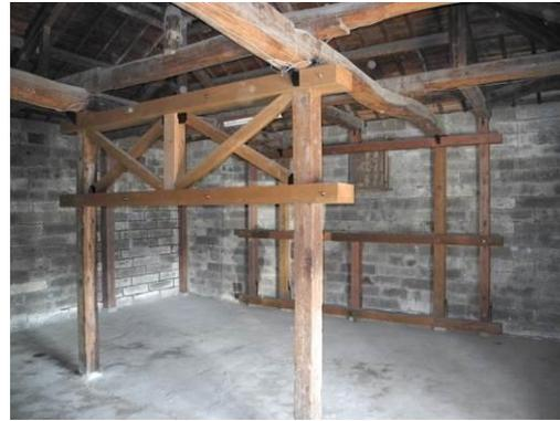
図 8 旧下野紡績所倉庫（復旧、構造補強）
