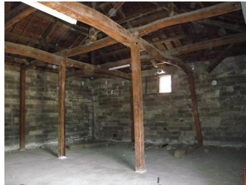
図 7 旧下野紡績所倉庫（震災による破損）
