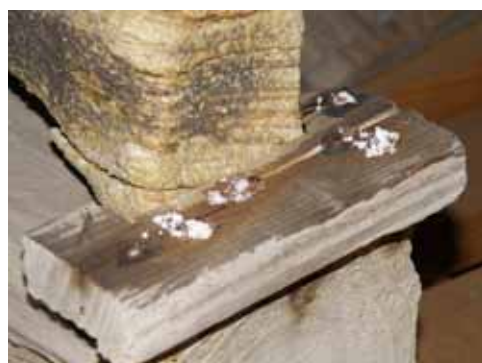
写真2. 鉄部の腐食
