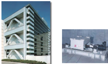
図2 可変剛性(AVS)建物と大型加振機
