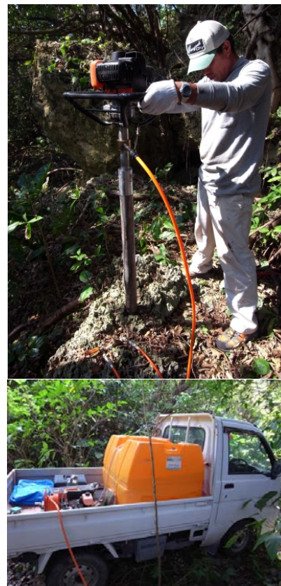
図2 浅層ボーリング掘削の様子
