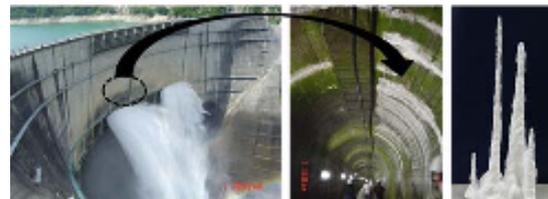
図-2 黒部ダムの内部トンネルに生成した2次生成物
